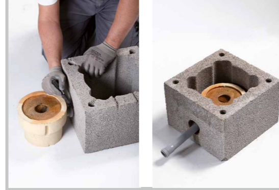
Märgi kondensaadikoguja ava asukoht mantelplokile.
