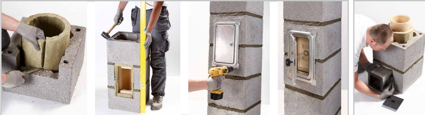
Aseta vill mantelplokki ning tee sisselõige puhastustoru jaoks.
